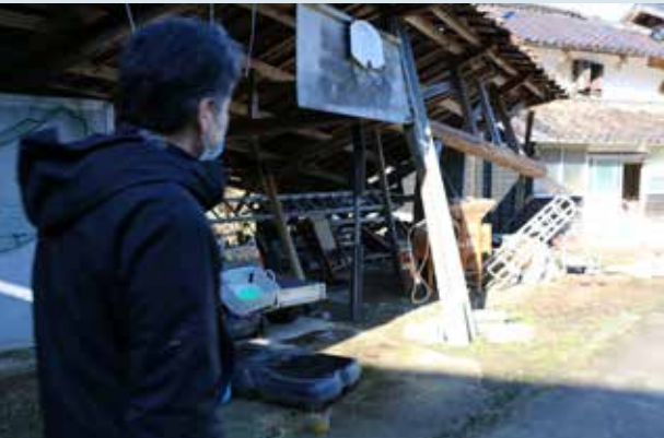
① [ 2024年2月16日 ] 志賀町個人宅 現地調査
