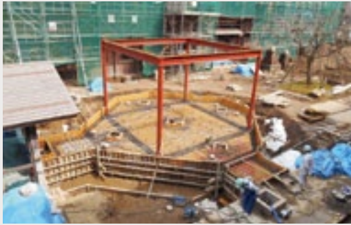
ほっとサロン建設工事状況（第1・2棟間の中庭 2014.3.12）
