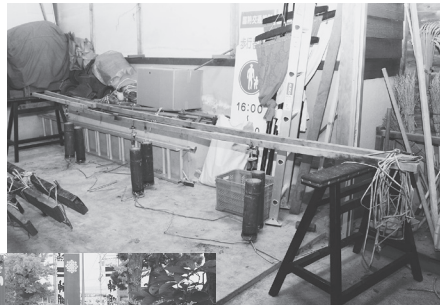
図3-3 吊り上げ前の四方吹き 2013. 9. 23
