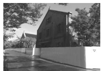
躯体工事開始
